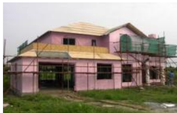
屋面及防水作业
