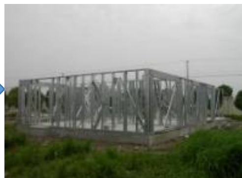
墙体结构安装
