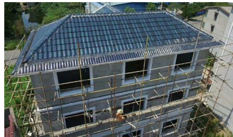
项目名称: 鄂州市泽林镇下王湾汉瓦项目 项目亮点: 鄂州城乡结合部第一家使用汉瓦发电案例 装机容量: 7.8KW
