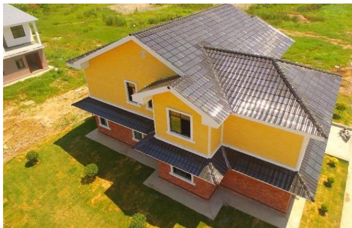
项目名称: 宿州市泗县城关镇东三环汉瓦项目 项目亮点: 该项目作为泗县第一套汉瓦案例, 在当地起到很好的示范意义 装机容量: 18KW
