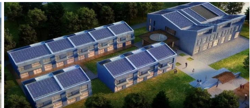
项目名称：河南五方科技馆汉瓦项目 项目亮点：中原地区首个超低能耗建筑和国家十三五重大科研课题示范项目 装机容量：9kw屋顶
