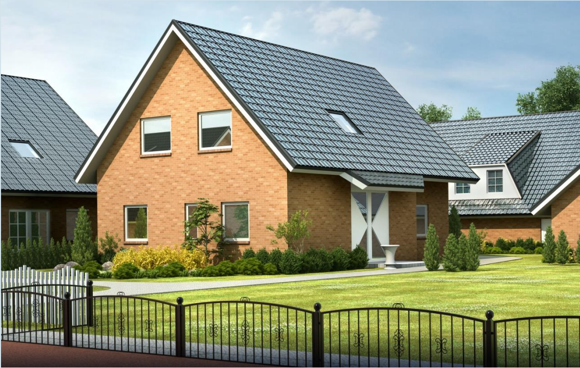
项目：德国三曲瓦项目 竣工时间：2017年11月 装机容量：12千瓦
