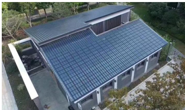
项目名称：杭州市余杭区龙兴文化公园公厕汉瓦项目 项目亮点：汉瓦组件在国内首个公共设施曲面屋顶项目。 装机容量：7KW
