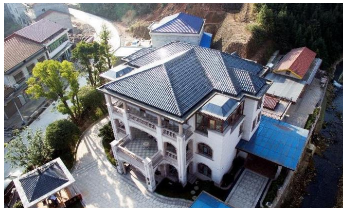
项目名称: 益阳市安化县常安村刘先生别墅汉瓦项目 项目亮点: 湖南首套汉瓦样板, 具有良好的品牌示范效应 装机容量: 17.1KW
