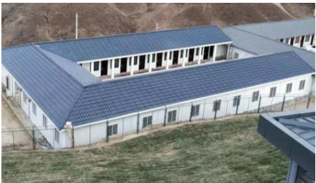
榆林石茆遗址汉瓦项目 2017年10月, 15Kw
