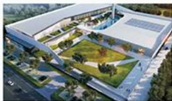
图四 北海数据中心
