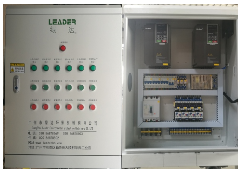
可靠规范的电控系统，双变频设计
