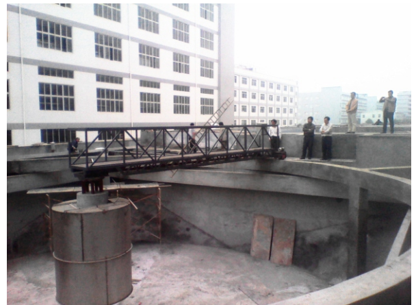
深圳周边传动刮泥机安装现场
